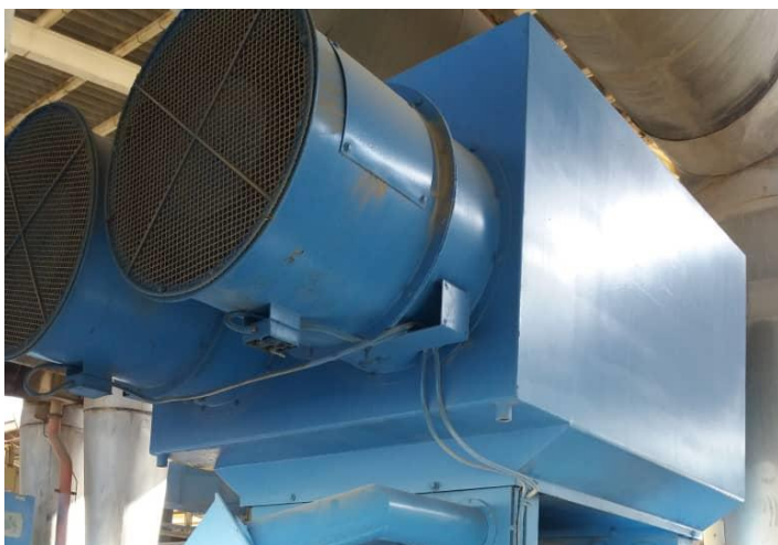
مبدل حرارتی هوا خنک (Air Cooler)
